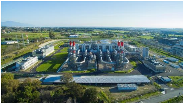
Construction de la nouvelle centrale électrique du Ricanto
