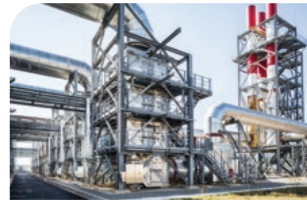
La centrale de Lucciana B, exploitée par EDF PEI, fonctionne au fioul domestique en attendant l'arrivée du gaz naturel dans l'île
