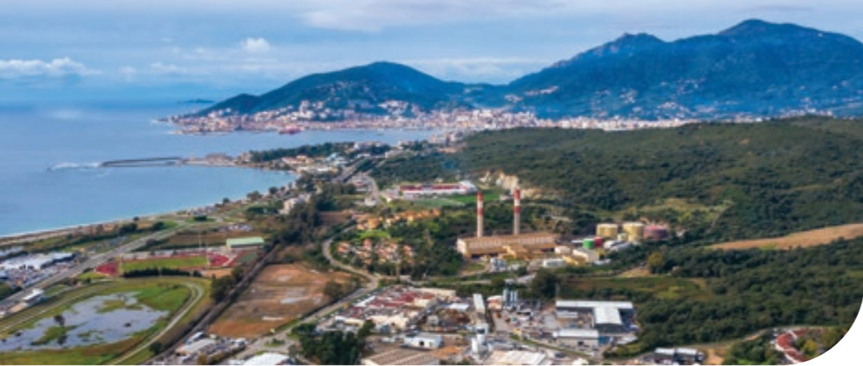
La centrale du Vazio : principale source d'alimentation de la région d'Ajaccio
